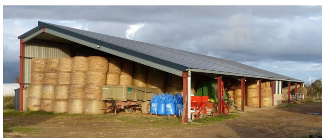
Bâtiment mixte stockage et stabulation (les Fresses)
