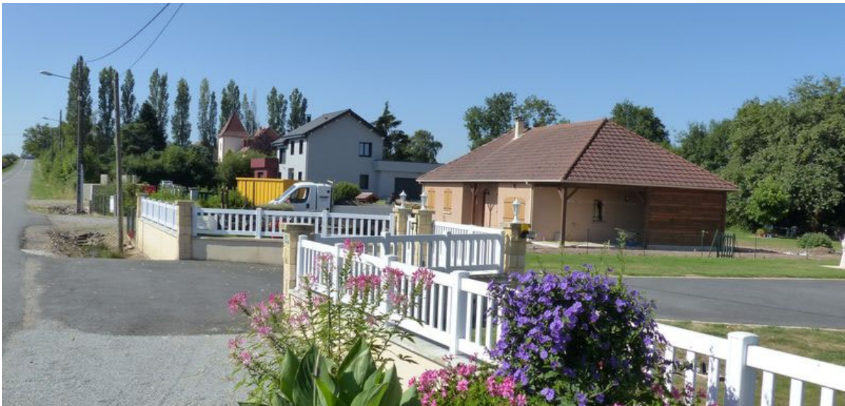
Constructions récentes aux Chaumes le long de la RD 996
