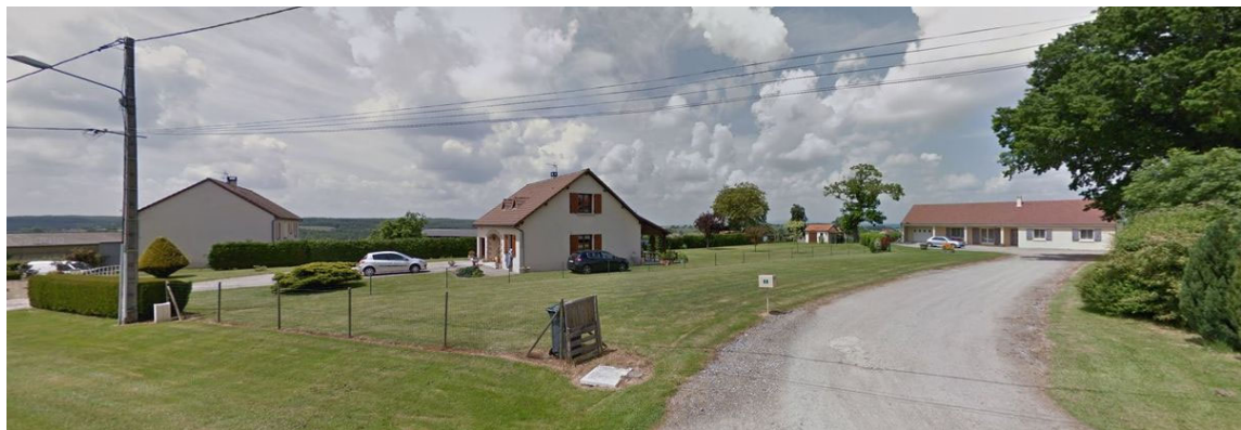
Constructions récentes au sud du village en bordure de la route des acacias
