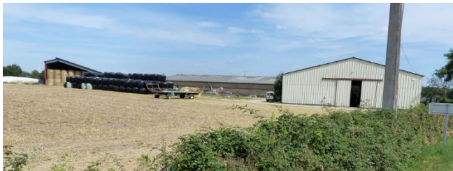
Ensemble de bâtiments agricoles au sud-est
