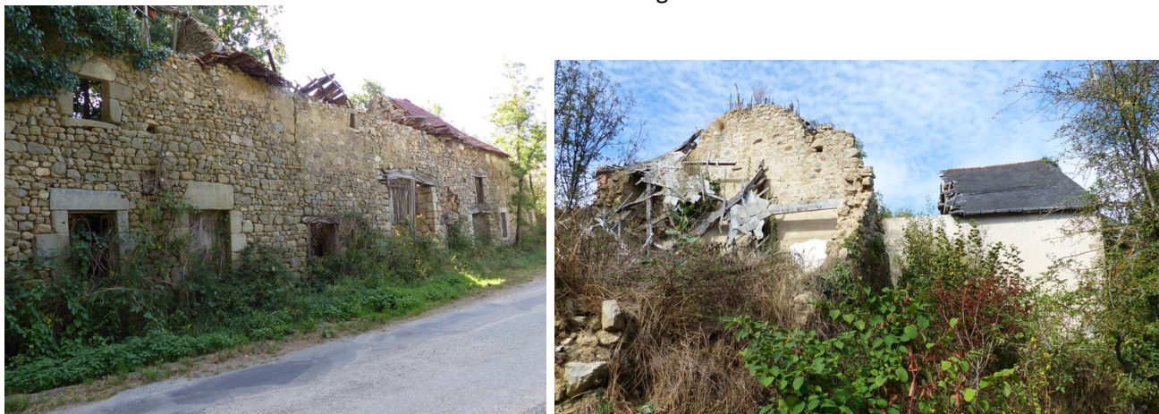
Maisons qui s'effondrent au cœur du village
