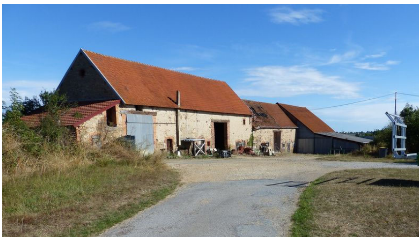
Bâtiments agricoles anciens
